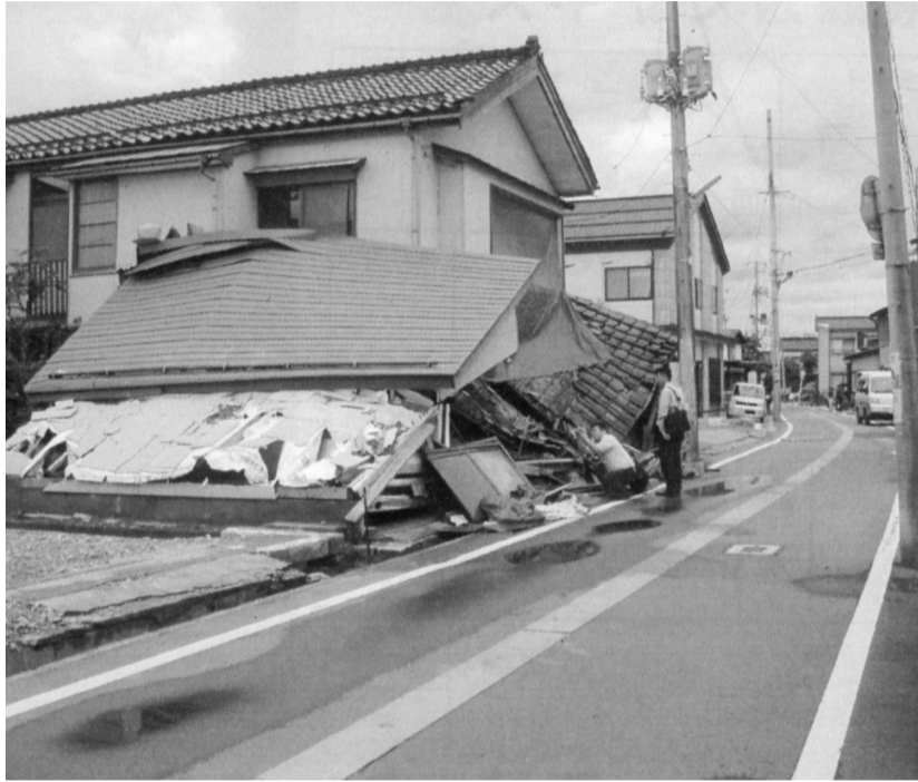
倒壊調査を行うスタッフ
